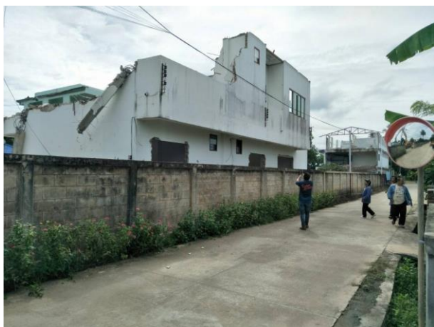
拆卸同工宿舍
